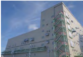
高吸水性樹脂プラント
